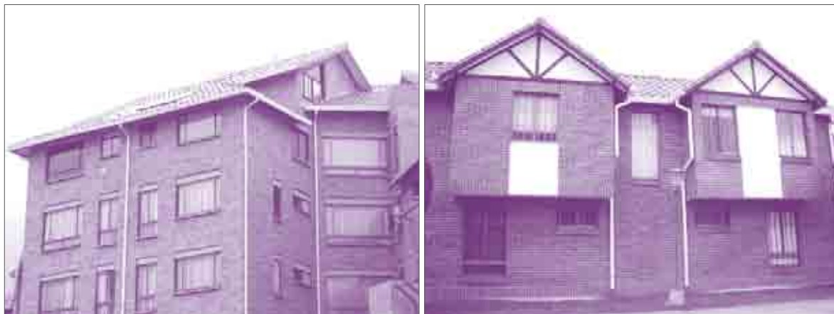
Figura 11. Tipologías de imitación colonial. Edificios y casas de finales del siglo XX y comienzos del XXI, con cubiertas en teja de barro.
